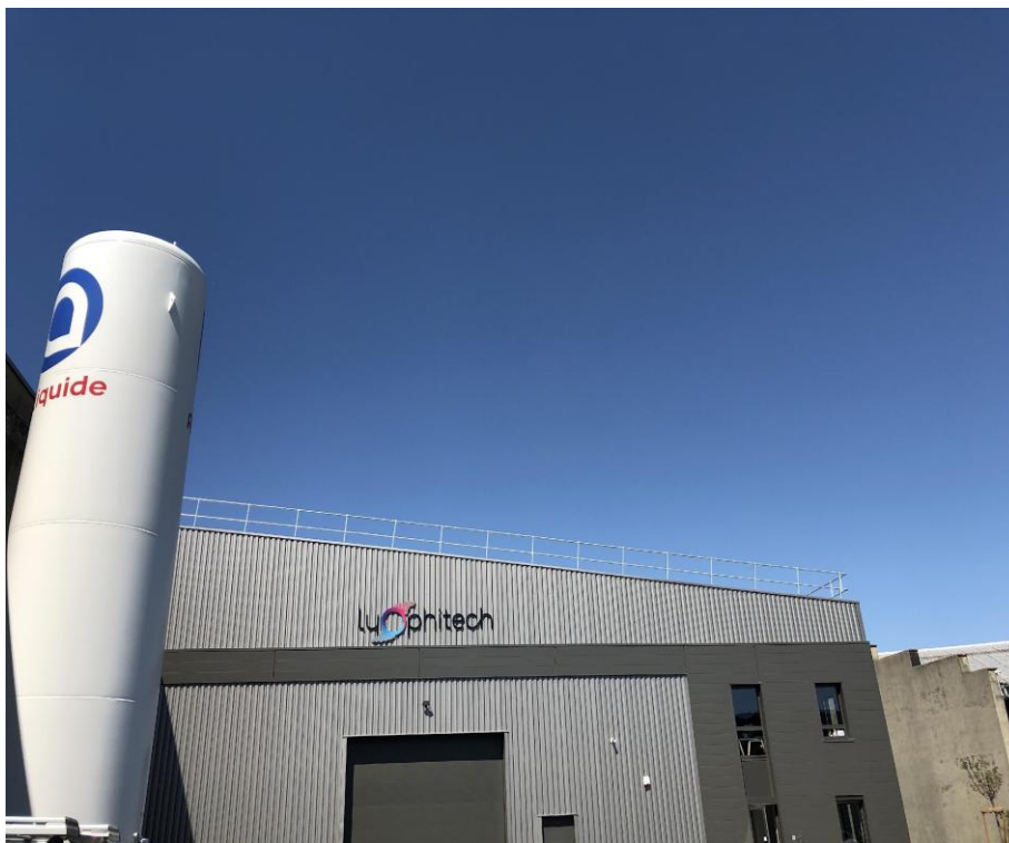
Photo du stockage Air Liquide devant le site Lyophitech
